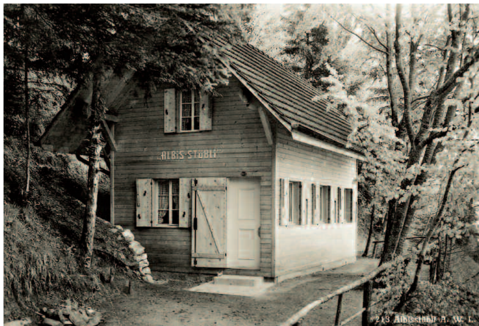
Postkarte, aufgenommen von «Rud. Suter, Photograph. Anstalt, Oberrieden-Zch». Aufnahmedatum zwischen 1947 (Bau der Stützmauer) und 1964 (die Stützmauer wurde durch Eisenbahnschwellen ersetzt).
