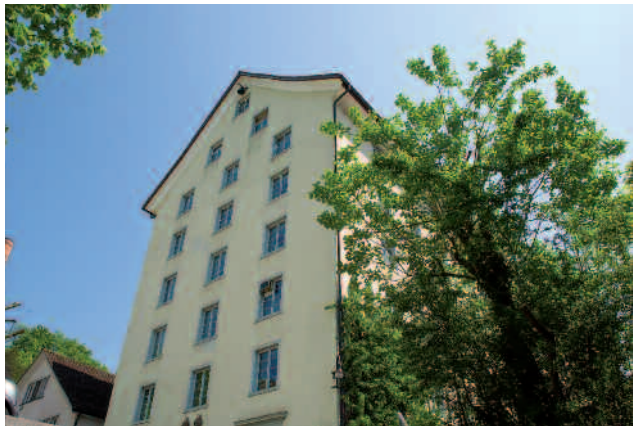
Das markante Spinnerei-Areal beherbergt heute rund vier Dutzend Betriebe.
