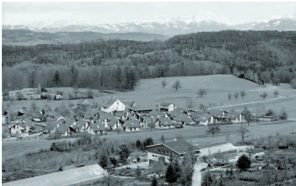
Blick Richtung Südosten im Jahr 1987 auf die Wohnquartiere an der Riedackerstrasse und am Grossackerweg. Vorne das Areal der Firma Grueber + Co. an der Striempelstrasse.
