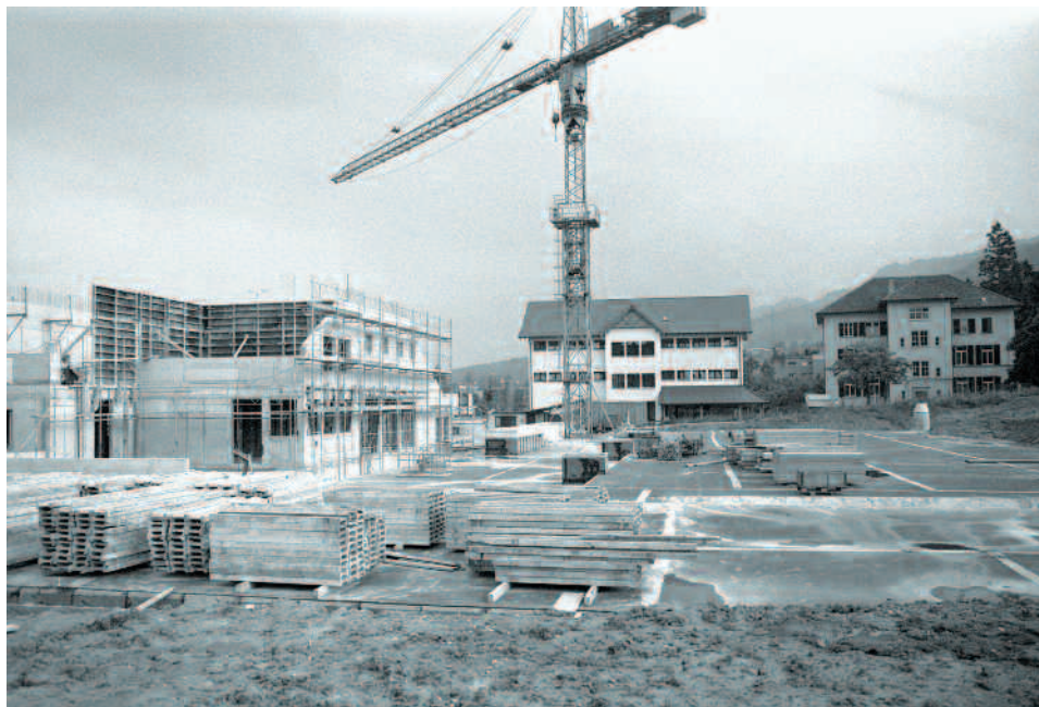
Stand der Arbeiten am 11. Juni 1983.
