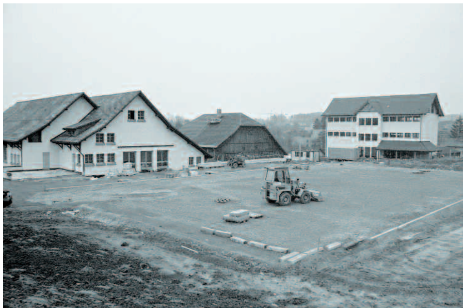
Im April 1984 wird die Zivilschutzstelle gebaut.
